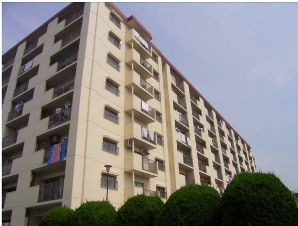
写真 1.1 建物外観写真（改修前）
