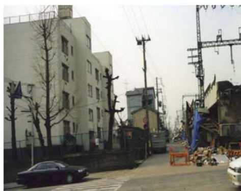
RC造・壁式構造の住棟（4階建て）
