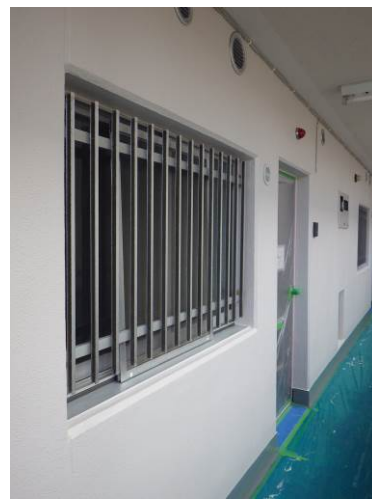
写真 2.3 補強部写真 （補強後）内廊下
