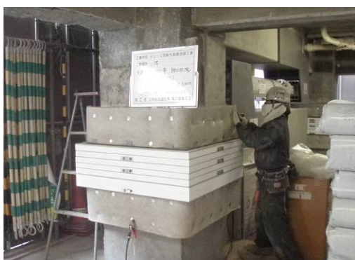
免震装置への耐火被覆の設置
