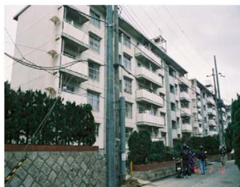
PC板構造の住棟（5階建て）
