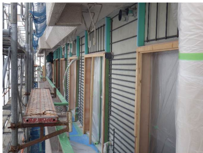
鉄筋取付状況
