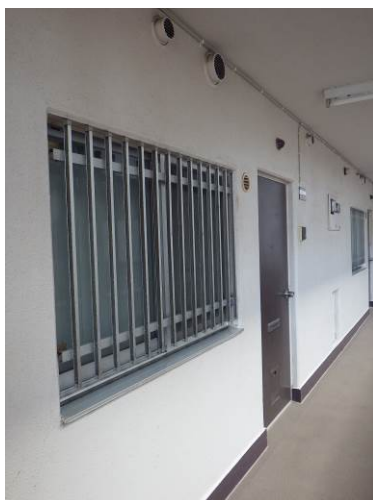
写真 2.2 補強部写真 （補強前）内廊下
