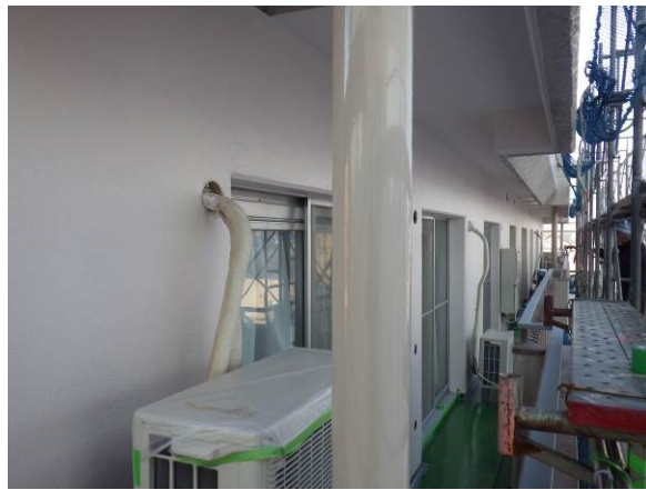
写真 2.5 補強部写真（補強後）ベランダ
