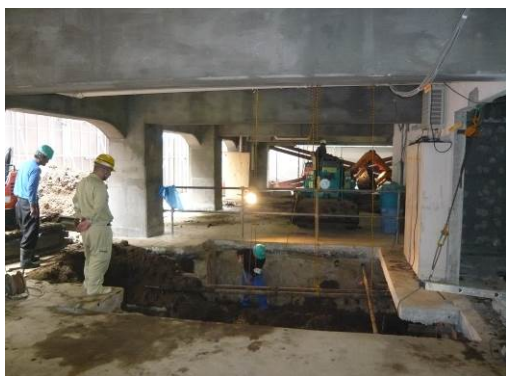
基礎梁補強のための掘削状況
